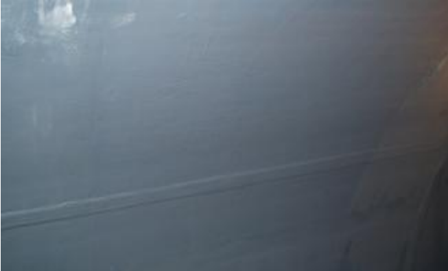
10. Aplicação da segunda camada de Belzona® 1321.
