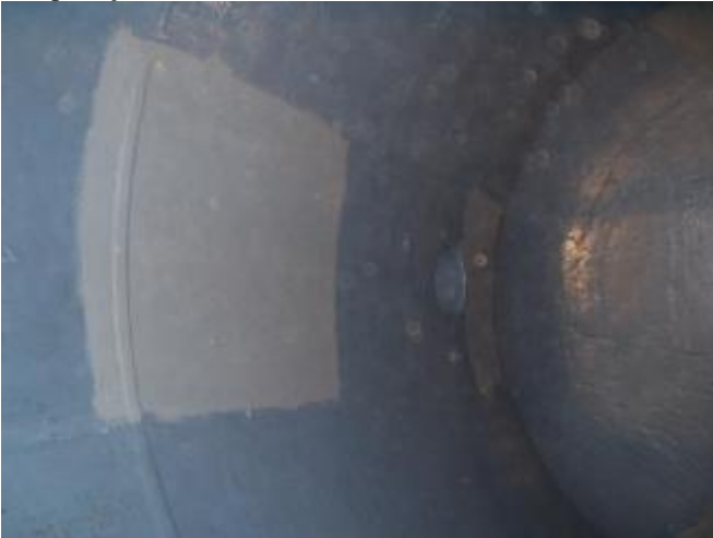
10. Aplicação da segunda camada de Belzona® 1321.
