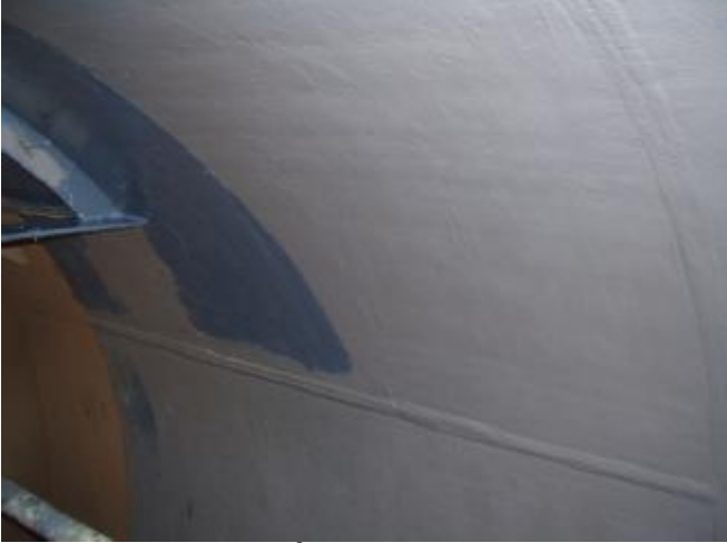
8. Aplicação de Belzona® 1321.
