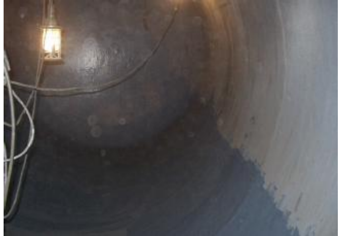
11. Serviço concluído após aplicação dos produtos Belzona®.
