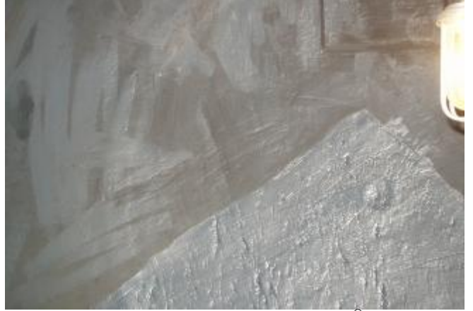
7. Bota do vaso durante aplicação de Belzona® 1321.
