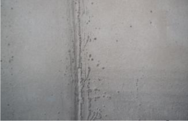
6. Aplicação da primeira camada de Belzona® 1321.
