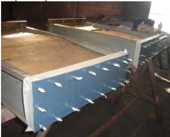
6. Espelhos revestidos com Belzona®1391.
