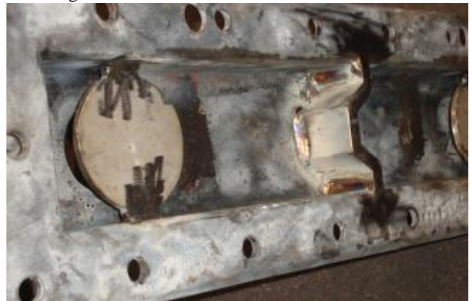
4. Espelho após preparação com jato.
