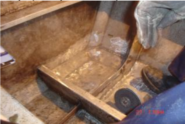
5. Término da preparação de superfície.
