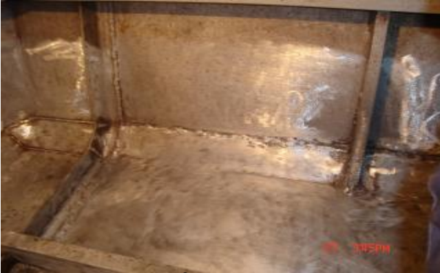
6. Aplicação de Belzona® 1121 na região de soldas.
