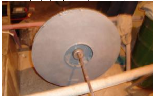
2. Após aplicação da 1ª camada do Belzona ® 1321.
