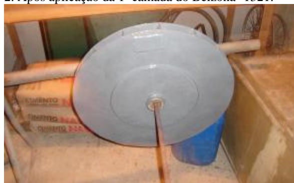
3. Após aplicação da 2ª camada do Belzona ® 1321.
