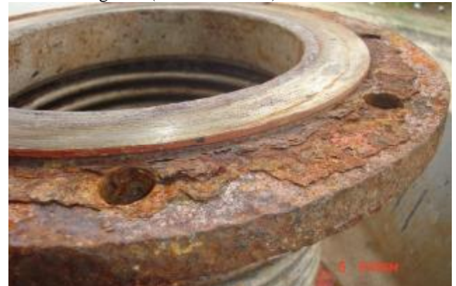
3. Preparação de superfície remoção da corrosão.
