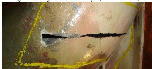
3. Preparação de superfície remoção da fibra de vidro.
