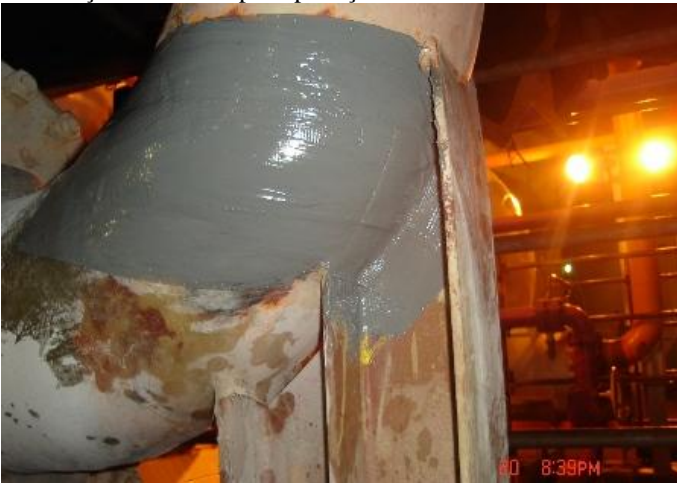
8. Serviço concluído após aplicação do Belzona® 4301.
