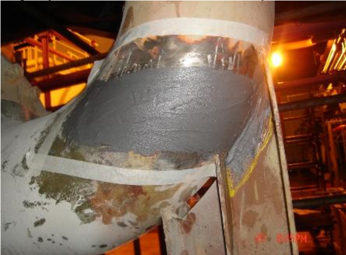
8. Serviço concluído após aplicação do Belzona® 4301.
