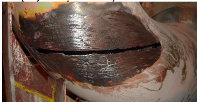
4. Aplicação de Belzona ® 1221.
