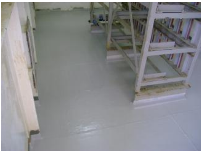
8. Piso revestido com Belzona® 5891.
