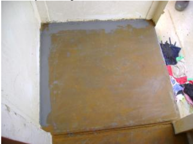
4. Suavização dos desgastes com Belzona® 1121.
