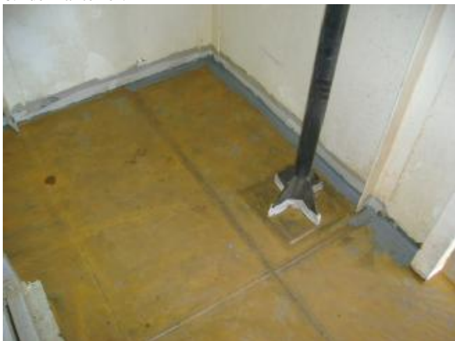
8. Piso revestido com Belzona® 5891.
