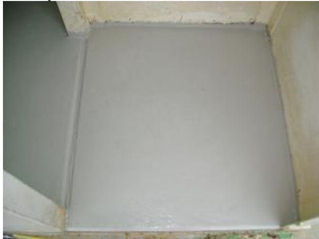
5. Piso após revestimento com Belzona® 5891.
