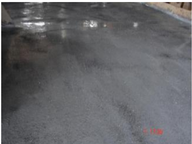
9. Aplicação da 2ª camada de Belzona® 5111 com agregado.
