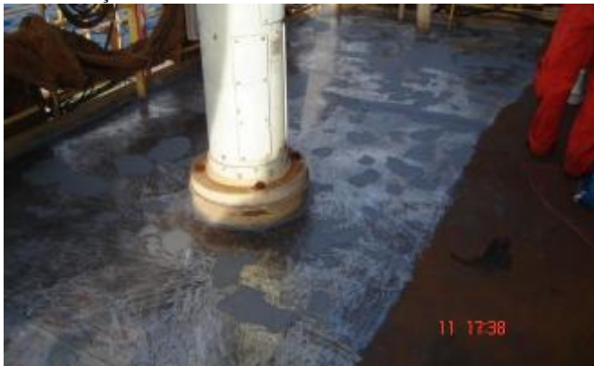
5. Vedação das regiões com incidência de infiltração e desgastes com utilização de Belzona® 1121
