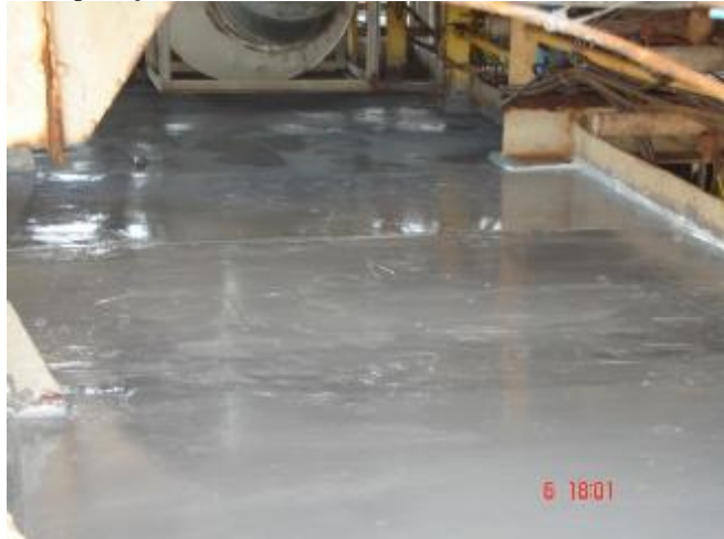
8. Aplicação da 1ª camada de Belzona® 5111.
