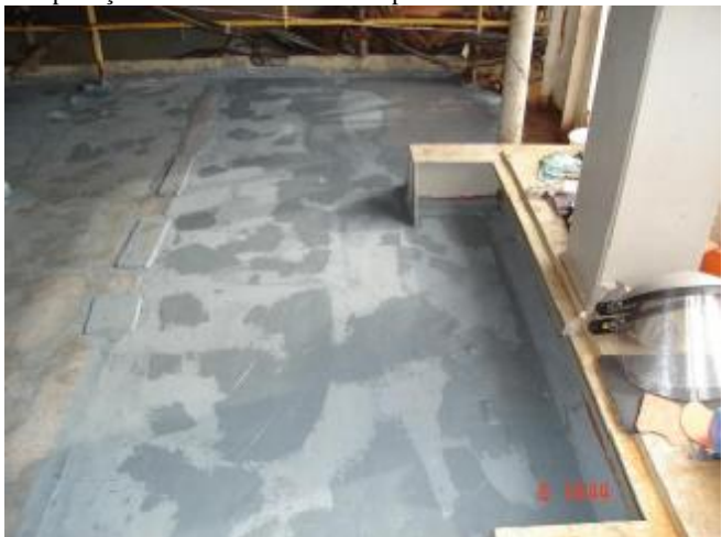
7. Aplicação do condicionador de superfície Belzona® 3921.
