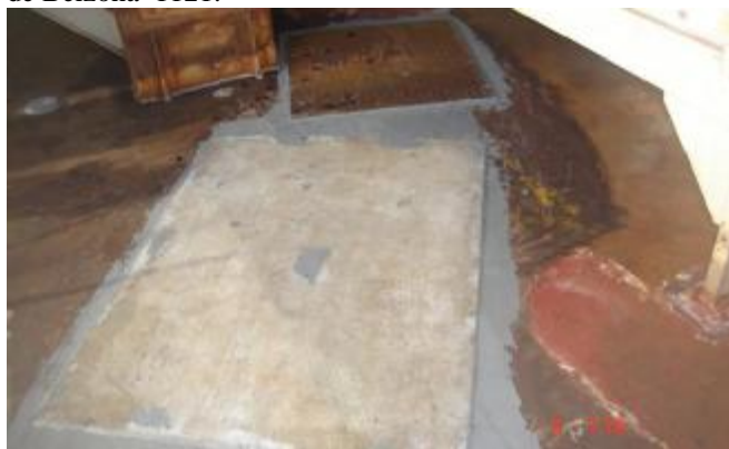
8. Aplicação da 1ª camada de Belzona® 5111.
