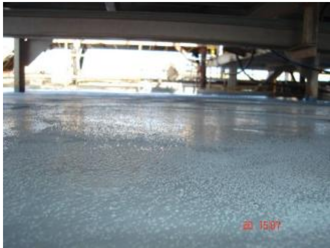
10. Serviço concluído após aplicação da 3ª camada de Belzona® 5111.
