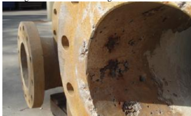
3. Recuperação de pites/alvéolos com Belzona ® 1111
