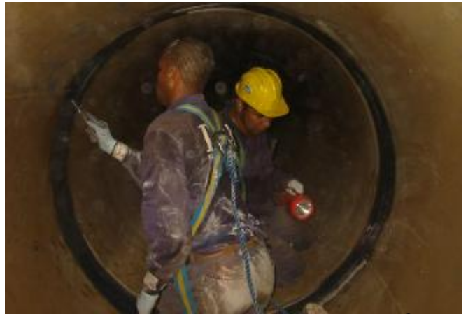
10. Cordões de solda após revestimento com Belzona® 1321.
