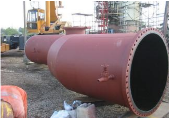
6. Duto após 2ª camada de Belzona® 5811.
