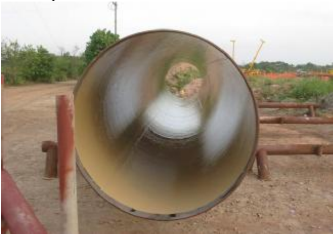
7. Técnico da HITA verificando espessura do revestimento.
