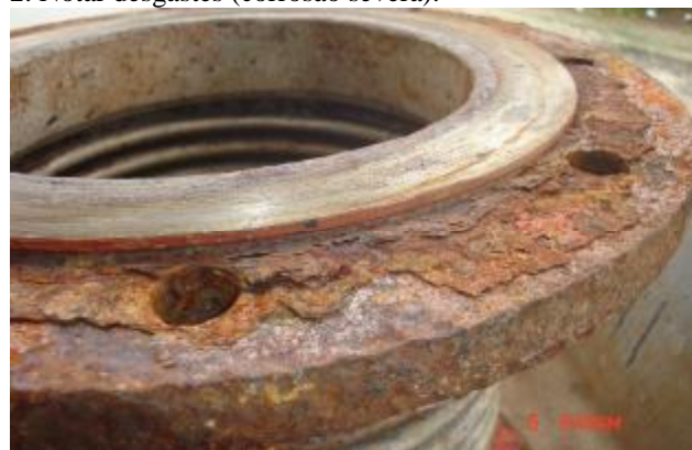
3. Preparação de superfície remoção da corrosão.
