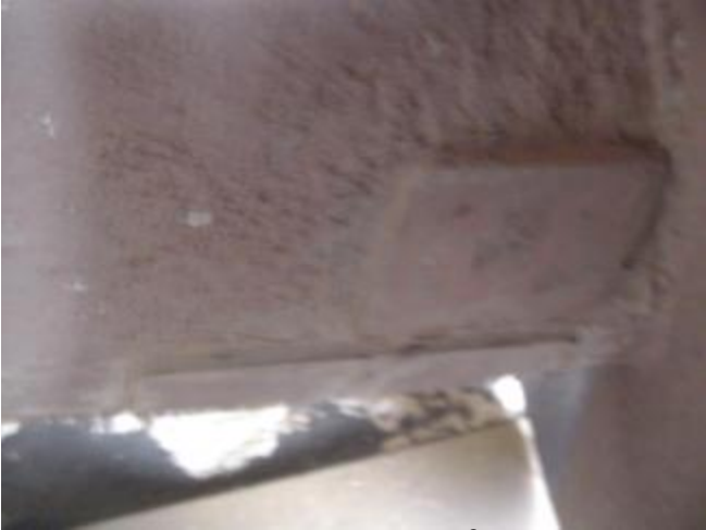
5. Aplicação dos revestimentos Belzona® 1321X e Belzona® 5891X.
