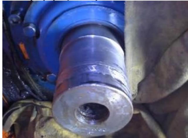
3. Eixo após preparação da superfície.
