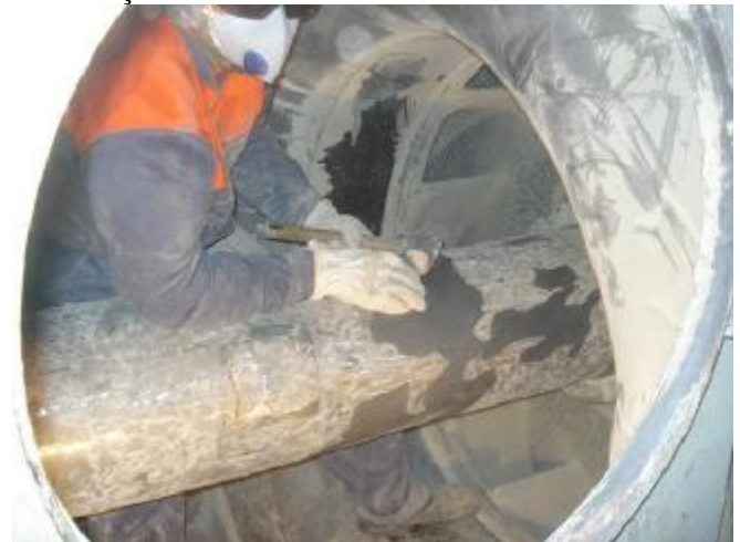
3. Remoção do revestimento anterior com talhadeira.
