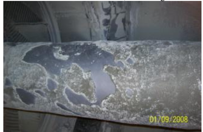
1. Eixo com revestimento anterior, notar desgastes.
