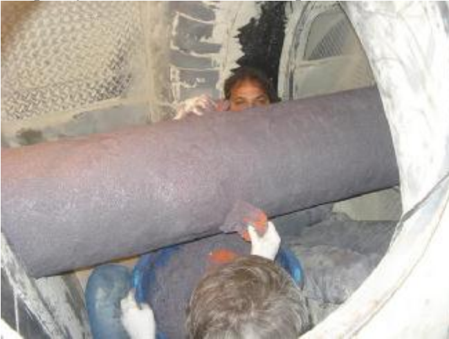
6. Aplicação de Belzona® 1812 na superfície do eixo.
