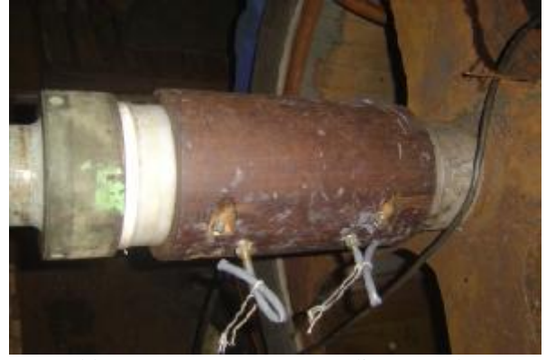
10. Molde após recuperação com aplicação Belzona® .
