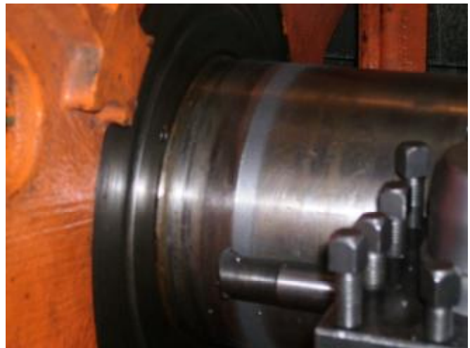
2. Usinagem final (acabamento) da área recuperada com Belzona ® 1111.
