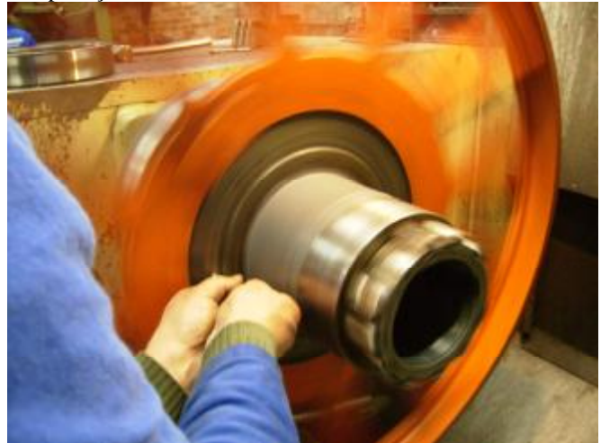
1. Aplicação de Belzona ® 1111.
