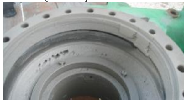
3. Sucção da bomba após jateamento.
