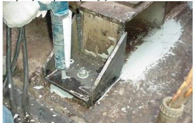
4. Base após aplicação dos produtos Belzona® 4111 / 4151.
