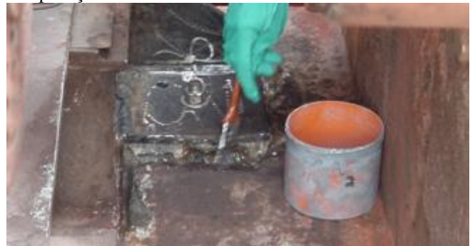
3. Aplicação do produto por injeção.
