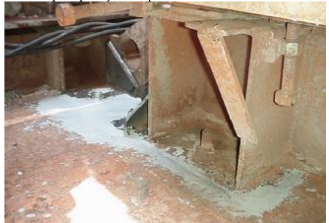
4. Base após aplicação dos produtos Belzona® 4111 / 4151.
