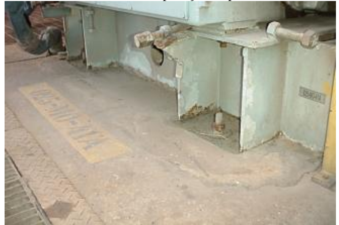
2. Aplicação do condicionador Belzona® 4911.
