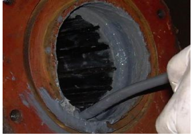
10. Fundo do alojamento após conclusão do serviço.
