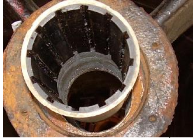
8. Preenchimento da folga com aplicação de Belzona®1321.
