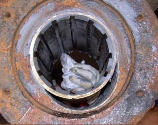
9. Serviço concluído após aplicação dos produtos Belzona®.
