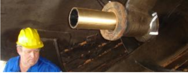
7. Aplicação de Belzona®1111 para fixação da bucha e suavização dos desgastes.
