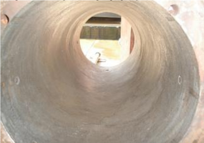
7. Aplicação de Belzona® 5811 no interior do alojamento.
