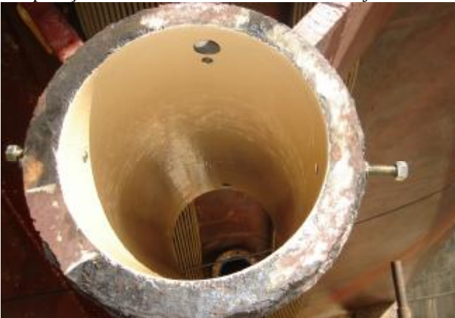
7. Aplicação de Belzona® 5811 no interior do alojamento.
