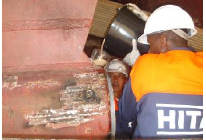
10. Serviço concluído, notar Belzona® 1121 na extremidade.
