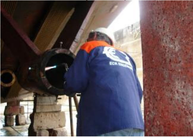
5. Preparação da superfície com lixadeira.
