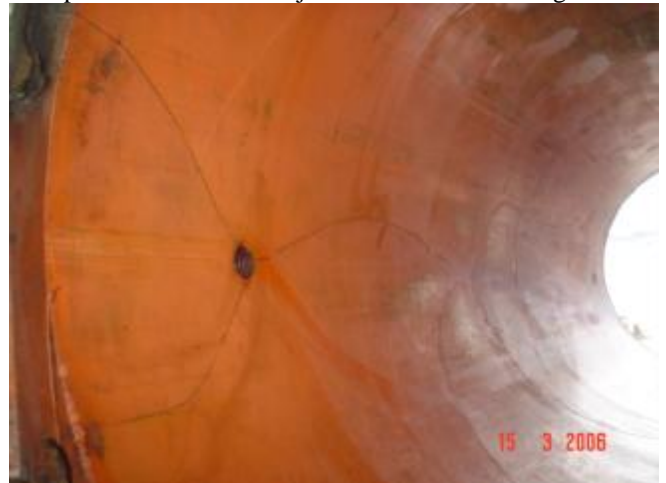
3. Superfície interna do alojamento com resina antiga.
