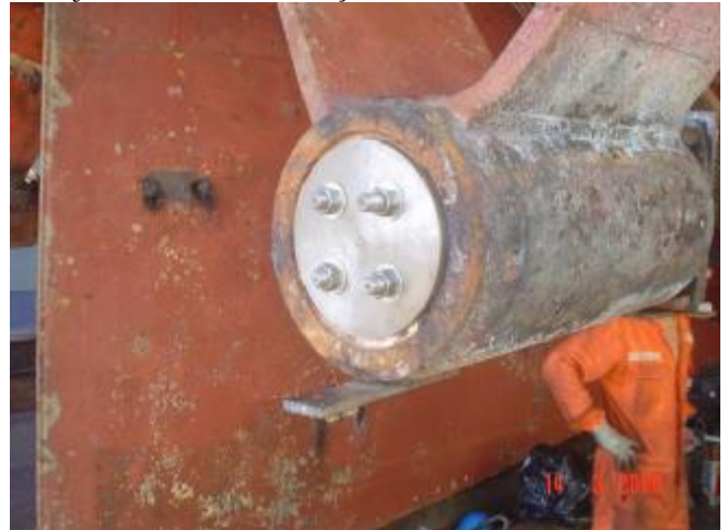
2. Alojamento antes do serviço.
